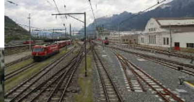
Gleisbau – Phase A
