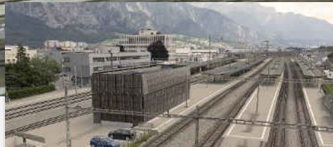
Gleisbau – Phase B
